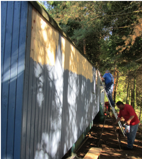
Neue Südseite am Bauwagen in Wieseth – Karl und Heinz bei den letzten Arbeiten
